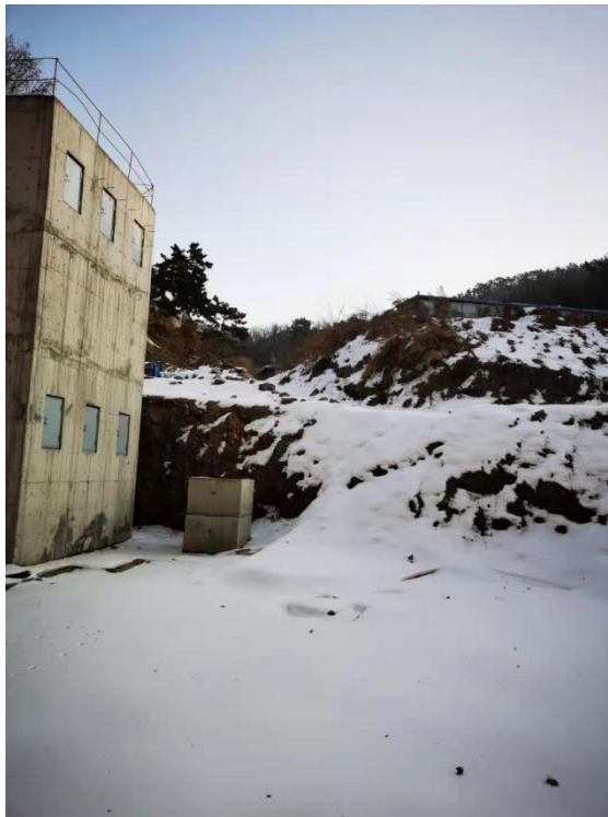
图 2 项目区现状图—实验室东侧场地现状
