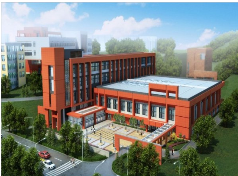
海洋生态环境整治修复实验室（在建，建筑面积：6,734 平方米）
