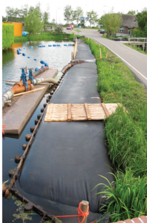
图 14 荷兰卡梅里克地区装有疏浚土的充填袋用于河岸防护
